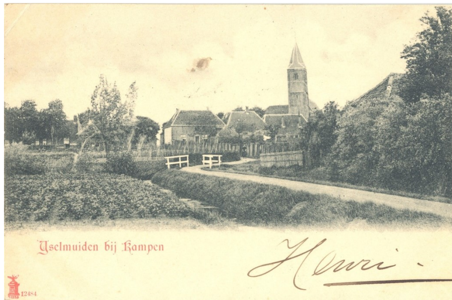
Zicht op de kerk vanuit de Baan - foto is van vóór 1912
