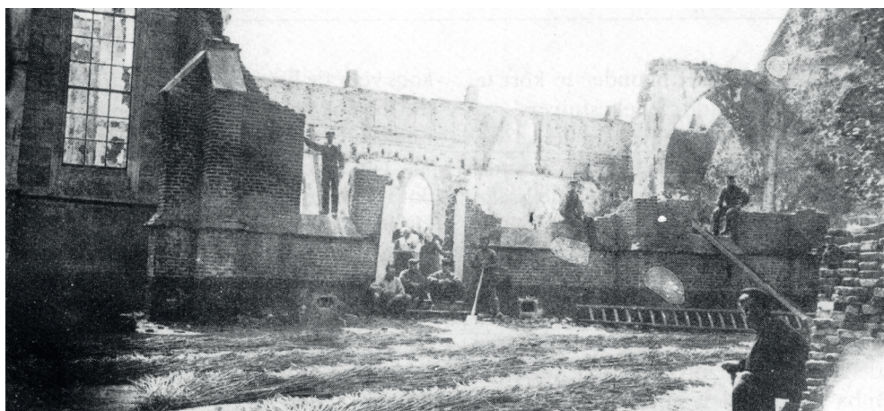
Een gedeelte van de verbrande Sint-Nicolaaskerk, links een gedeelte van het koor en rechts de westgevel met daartegen een nog intacte boog
